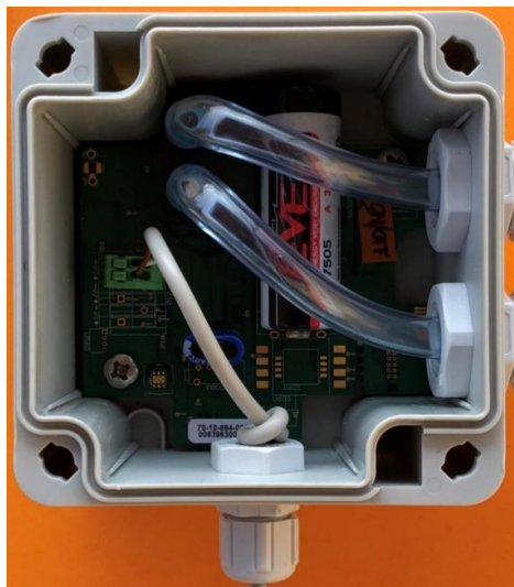
Figure 4 - Le capteur avec installation d'un câble S0
